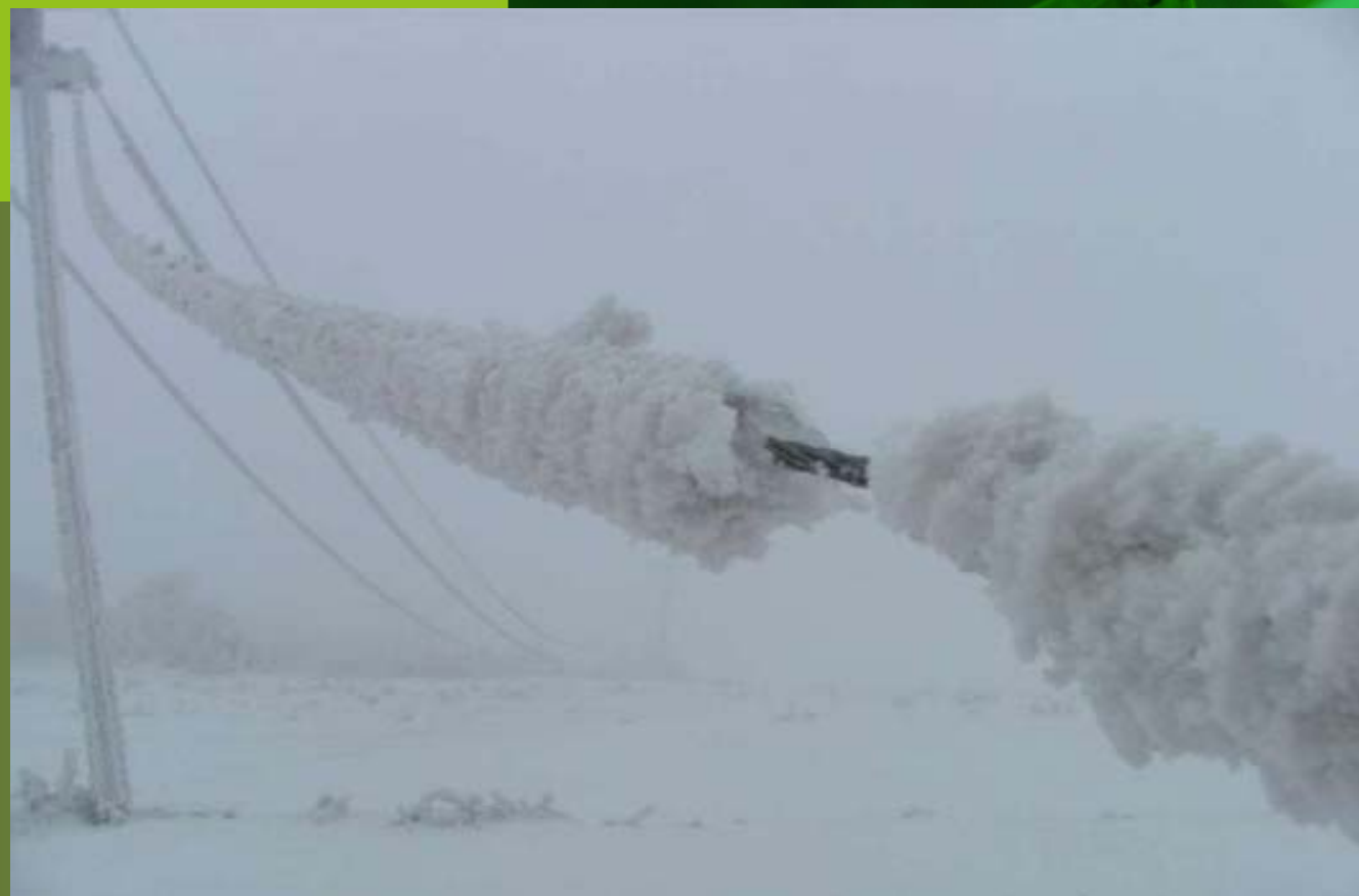
Rys 30. Ekstremalny nawis sadziowy na linii SN (zima 2010, Jura Krakowsko - Częstochowska)
